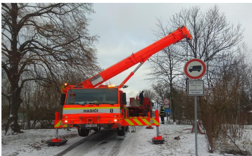
Obrázek 11- instalace mobilních zátarasů na hraničních přechodech
